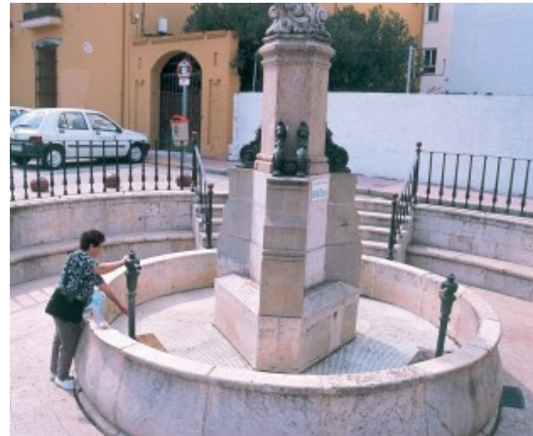
Vista de la Fuente Pública que abastece a la población de Vergel (Alicante - España)
